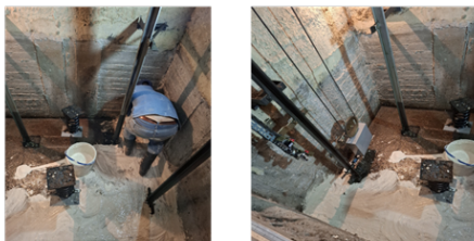
Impermeabilización del pozo torre 5.
