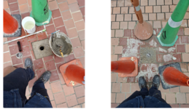
Aplicación de granito, al sifón frente torre 7
