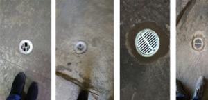
Cambio de rejillas rotas, en sótanos.
