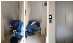
LIMPIEZA DE PUERTAS DE ASCENSORES
