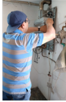
UnoAUno Acompañamiento al técnico, para reparación de calentador de las duchas de piscina. Queda funcionando bien.
