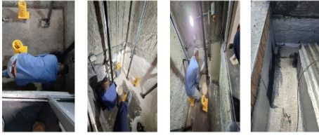
Impermeabilización del pozo ascensor torre 3
