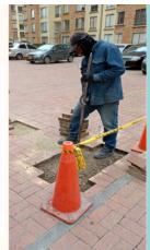
TERMINACIÓN PROYECTO CAMBIO DE ADOQUINES PARQUEADEROS - CONTRATISTA REPARACIONES LOCALIVAS RUIZ
