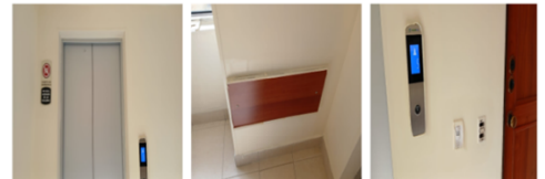
Seguimiento a enmascare, resane y pintura de paredes alrededor de puertas, botones y cajón de cableado, en cada piso torre 10.
