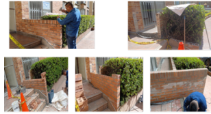
Intervención del muro torre 3.
