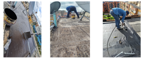
Instalación manto, en cubierta cuarto de maquinas torre 7.
