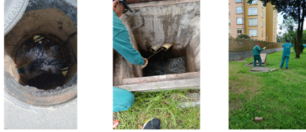
Acompañamiento al personal de acueducto con equipo de sondeo, se revisan todas las cajas.
