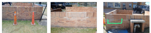
MANTENIMIENTO CORRECTIVO A PUNTO FIJO AL LADO DE LA CANCHA MÚLTIPLE POR LADRILLOS SUELTOS
