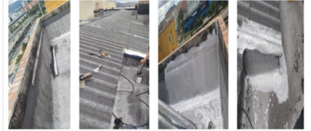
Impermeabilización cubierta torre 7, apto afectado 1004.
