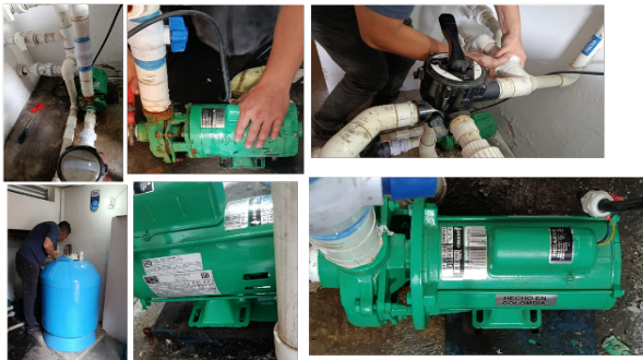
ARREGLO DE LA FLAUTA DEL SUMINISTRO DE AGUA POTABLE DE LA LÍNEA DE APARTAMENTOS #2 DE LA TORRE 7 POR FUGAS Y DETERIORO DE TUBO GALVANIZADO
