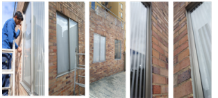
Resane, emboquillado y aplicación de impermeabilizante; en ventanas de la administración.
