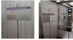
UnoAUno Instalación de cartelera en ascensores habilitados, quedando pendientes de torre 2,6,8,11 y 13.
