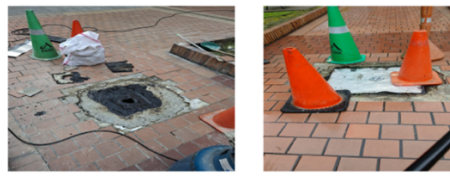
Cambio de codo sifón, por filtración de agua al sótano, frente torre 6.
