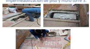
Impermeabilización de piso y muro torre 3.
