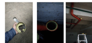
Limpieza y cambio de tubo sanitario, sobre parqueadero 316
