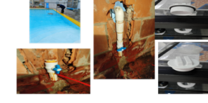
Se tapona la piscina, para cambiar válvula y así corregir filtración en parqueadero.
